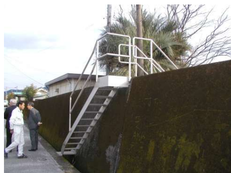
陸閘を廃止し、近接した場所に階段を設け、利便性を確保している事例(潮江地区)
