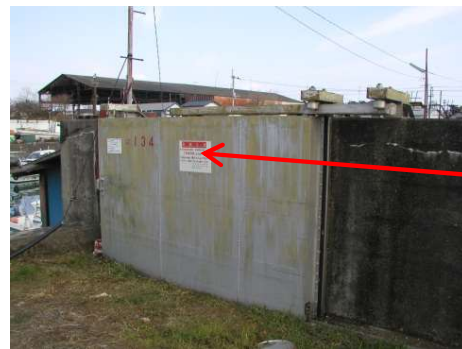
利用度の低い陸閘を常時閉鎖している事例(種崎地区)
