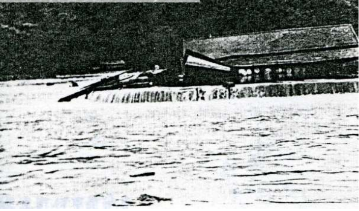
昭和35年チリ地震津波時の面瀬川沿川の被災状況
