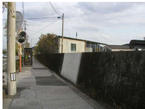
陸閘を廃止し、近接した場所に階段を設け、利便性を確保している事例(潮江地区)
