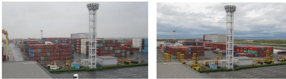
写真 3.2.2 コンテナの積み上げ段数の低減（左：対策前5段、右対策後3段以下）
