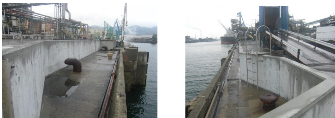
写真 3.5.2 岸壁水際部分の嵩上げ
