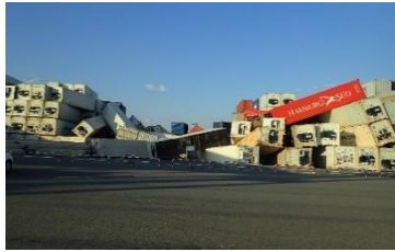
写真 2.3.1 コンテナの倒壊の状況
