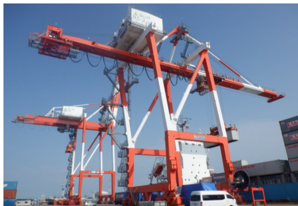
インバータ制御方式のガントリークレーン
