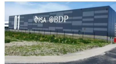
図5 PSAのダンケルク港EVバッテリー物流倉庫
