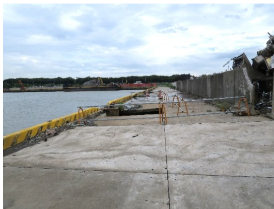
鋼矢板式岸壁
