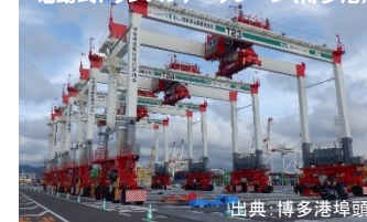
電動式トランスファークレーン(博多港)
