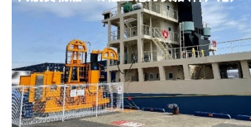
内航貨物船への陸上電力供給(神戸港)
