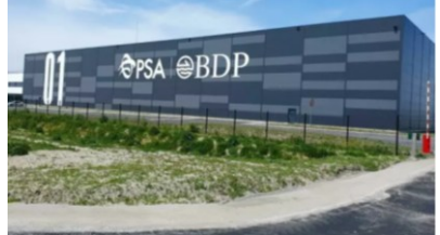
図5 PSAのダンケルク港EVバッテリー物流倉庫
