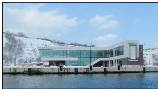
鴛泊港フェリーターミナル
