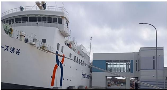
杓形港耐震岸壁・フェリーターミナル
