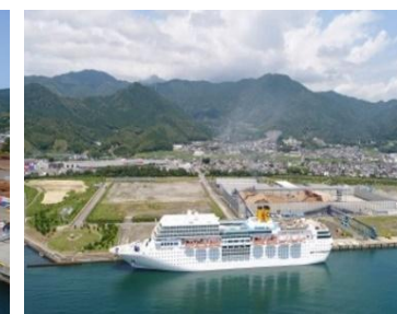
佐野第三号岸壁・荷捌き地
