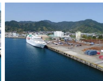
三輪崎第四岸壁・荷捌き地
