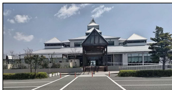
熊本港フェリーターミナル
