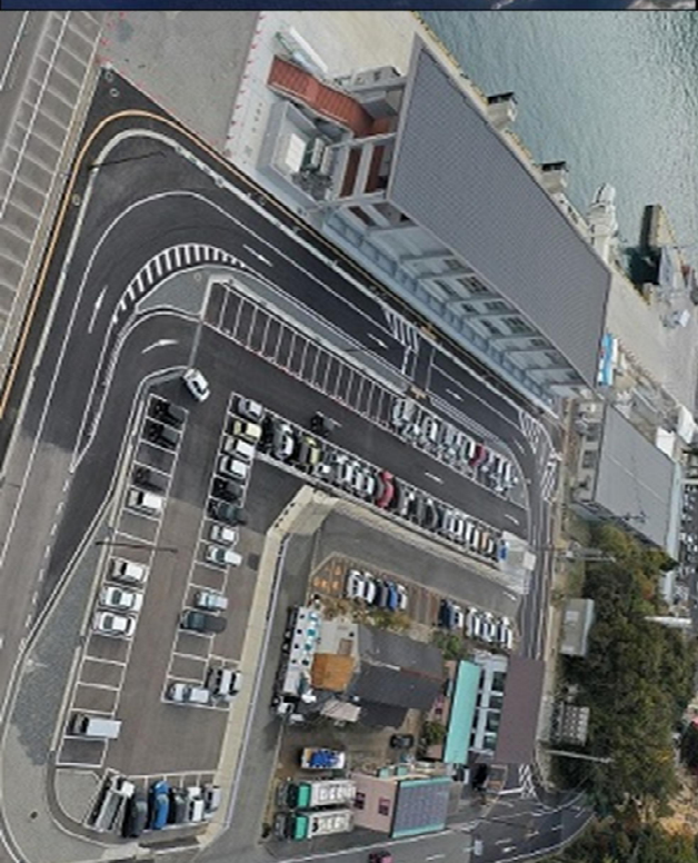
【代表施設】 厳原港国内ターミナル
