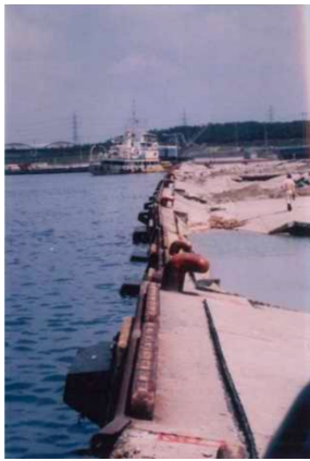
図 5-5 矢板が変形、損傷した事例（日本海中部地震） 19)
