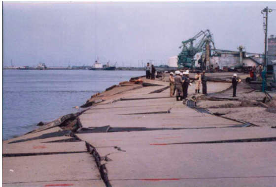
図 5-6 控え工の大きな変位に伴って矢板頭部が変位、矢板が傾斜した事例（日本海中部地震） 19)
