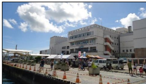
平良港マリンターミナルビル
