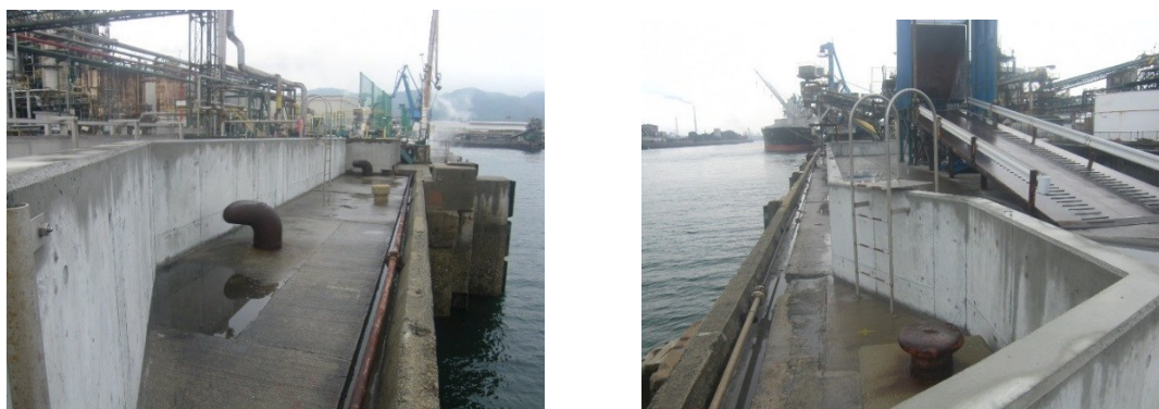
写真 3.5.2 岸壁水際部分の嵩上げ
