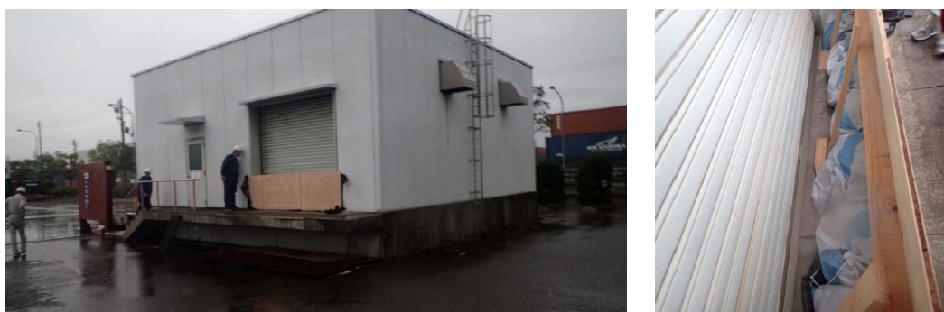
写真 3.1.3 合板や土のう等による電気設備への仮設止水板の設置
