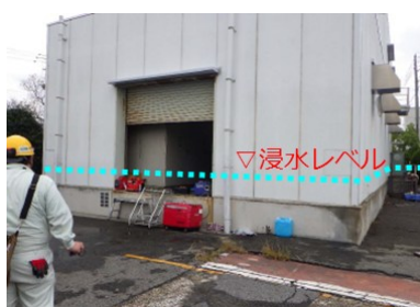
写真 2.2.1 受電所の浸水 (床上約 30cm)
