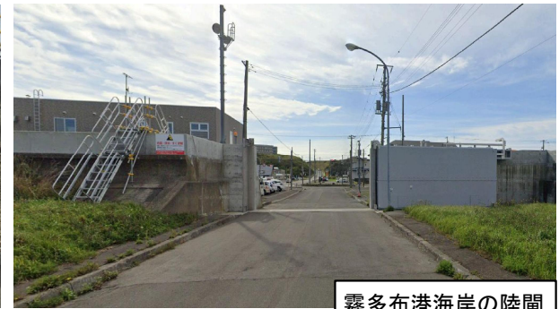
霧多布港海岸の陸閘
