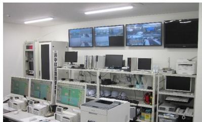
現 津波防災ステーション内部
