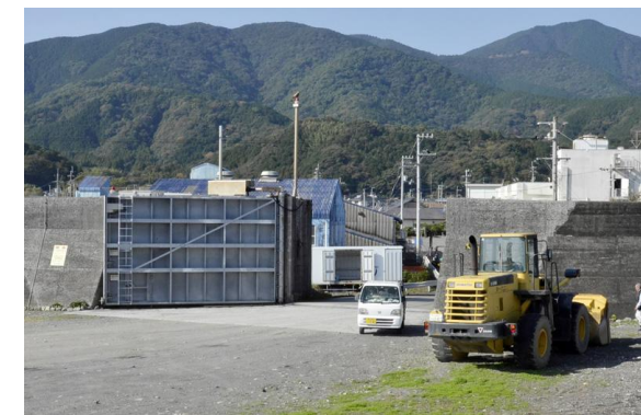
震度5強以上の地震の揺れを感知して自動で閉鎖する仕組み
