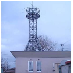
旧 津波防災ステーション (～2021年庁舎移転前)
