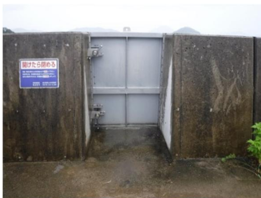
陸閘閉鎖訓練
