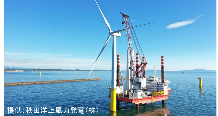
SEP船による海上施工の様子(能代港・秋田港内)
