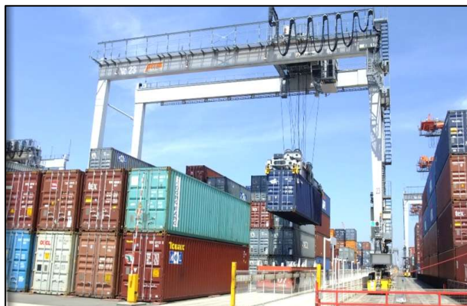
遠隔自働RTGとAGVの自働荷役 (アイドリングストップ・夜間消灯自働荷役)
