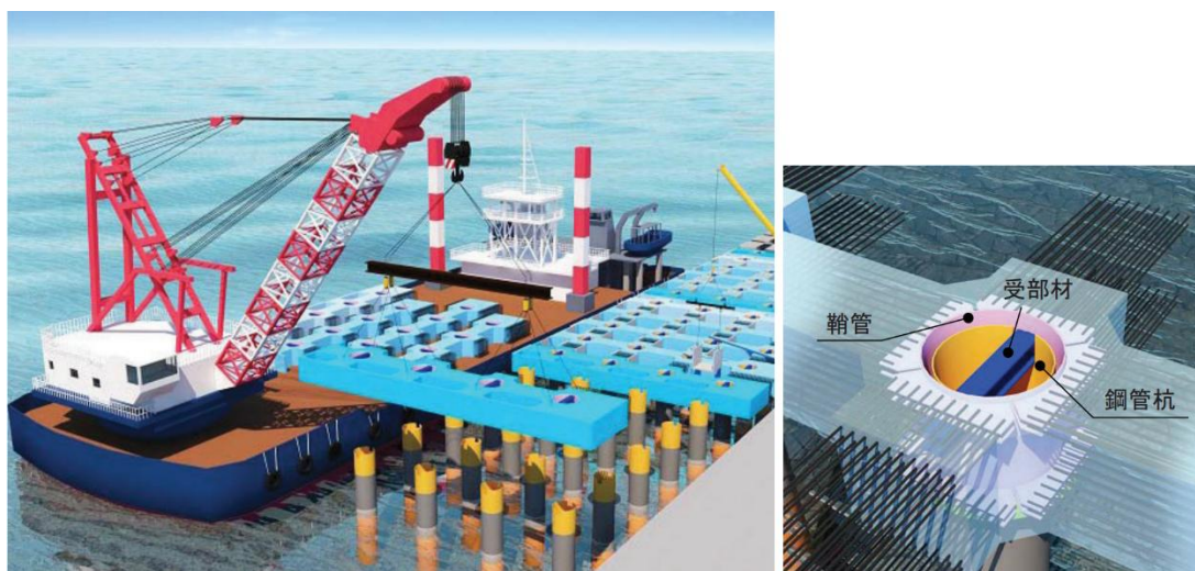
図 4-1 棧橋改良工事事例
