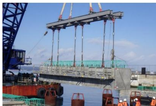
b) プレキャスト受梁据付状況
