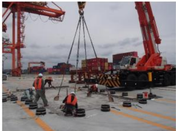
床版再設置(据付)
