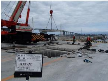
床版入替え(C部⇒B部)
