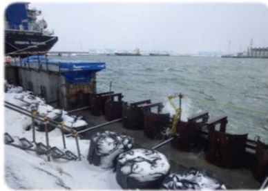
東地区水深12m岸壁整備箇所の擾乱状況
