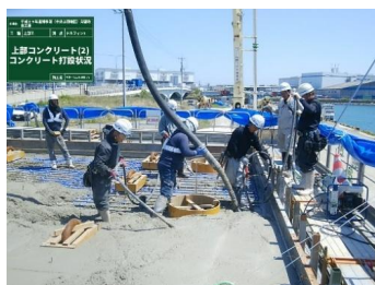
コンクリート打設
