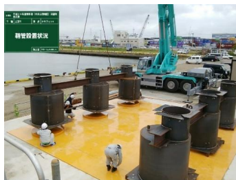
ト*ルフィン上部 鞘管設置
