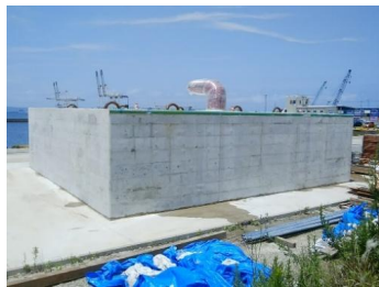
ドルフィン°レキャスト上部工製作完了
