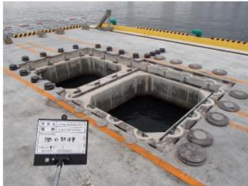
床版撤去完了
