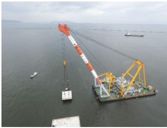
プレキャスト上部工設置状況
