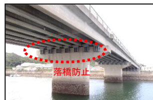
新居浜港 (橋梁の改良)
