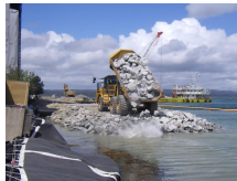
現地着工の状況(R7.4)
