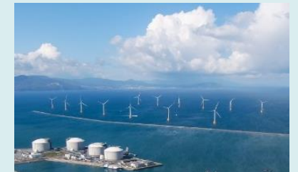
写真提供: 石狩湾新港管理組合
