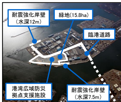
基幹的広域防災拠点（川崎港）
