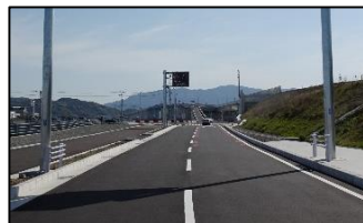
徳島小松島港 (臨港道路の整備)
