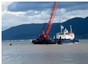
浚渫作業の状況(R6.10)
