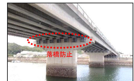
新居浜港 (橋梁の改良)
