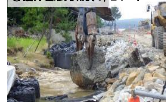
③護岸撤去状況(6/24~)
