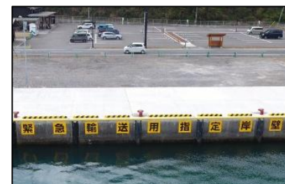
くれ 久礼港 (岸壁の改良)
