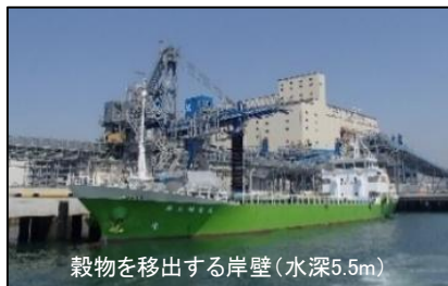
水島港 (岸壁の整備)
