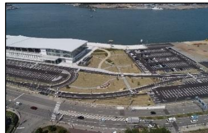
金沢港 (緑地・臨港道路の整備)
