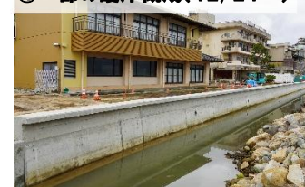
④一部の護岸概成(12/24~)
