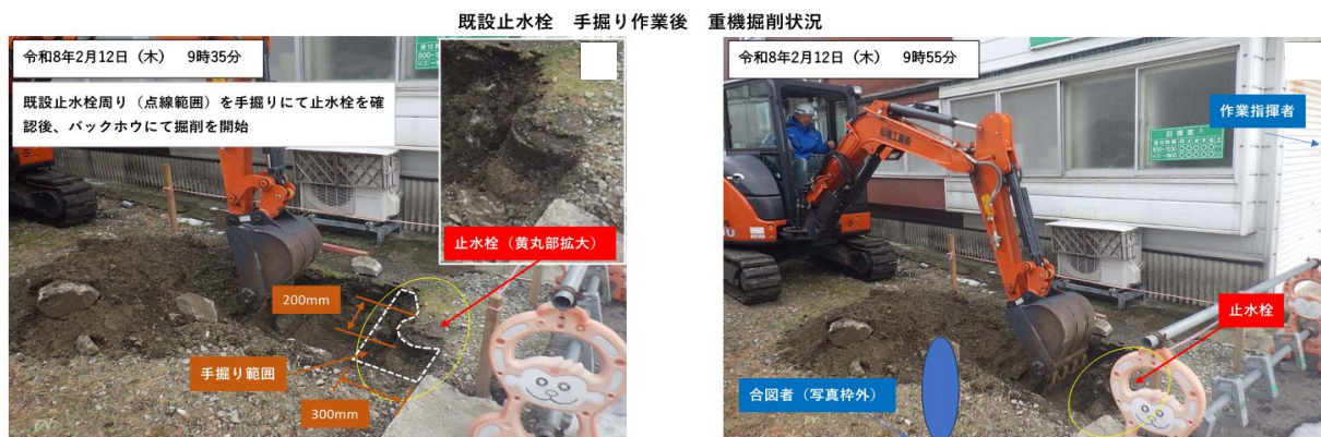
損傷させた止水栓の拡大写真及び物損対象物の埋設状況図
