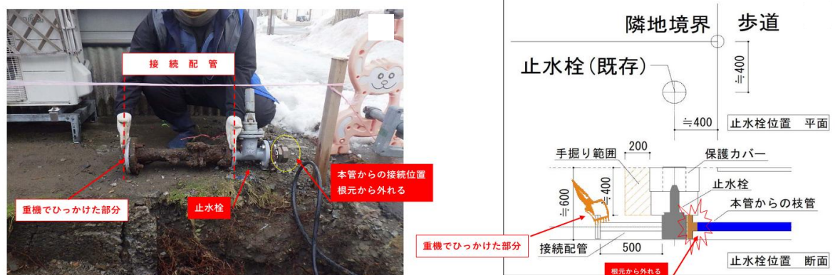
損傷させた止水栓の拡大写真及び物損対象物の埋設状況図
