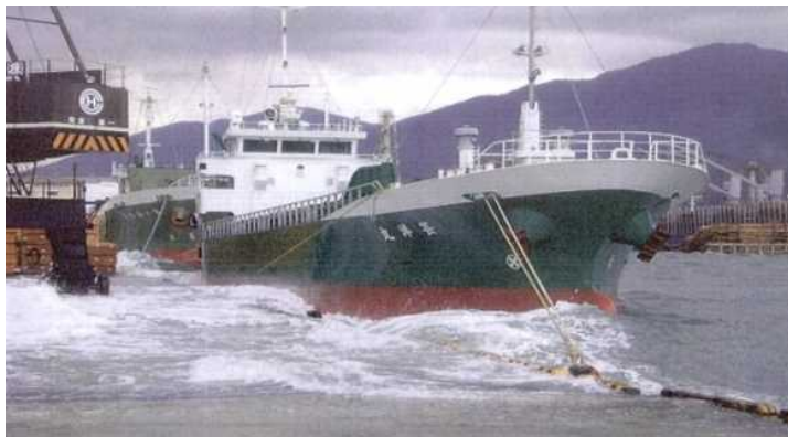
岸壁沈下に伴うエプロン浸水(呉港広地区)
