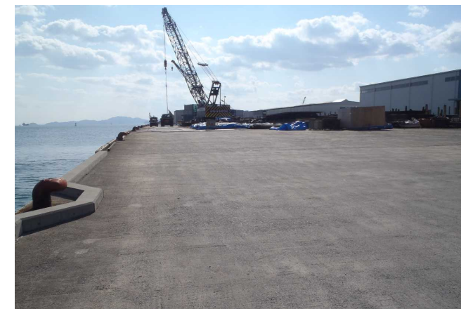
浸水被害防止のための暫定対策としての車止め嵩上げ
