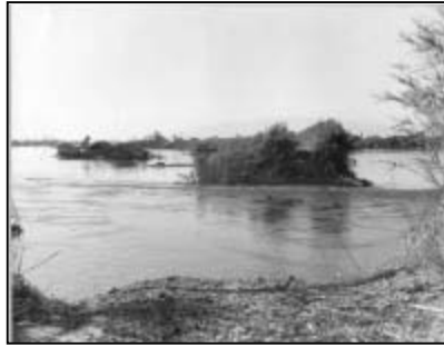
宝川せき止め作業（愛知県海部郡）
