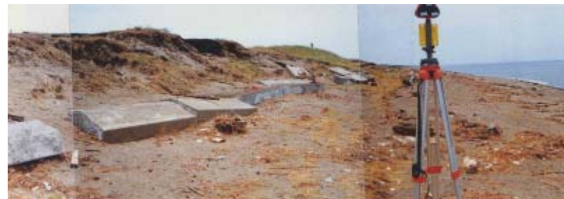
秋田県峰浜村の護岸倒壊 (秋田県沿岸津波実態調査報告書)
