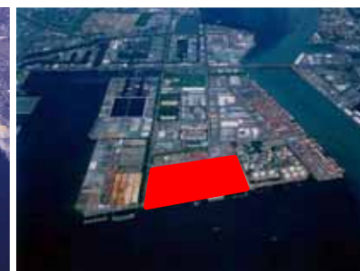
名古屋港飛島ふ頭南側CT
