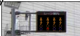
ゲート前状況監視施設・偏載監視施設 補助制度 [H19~]
