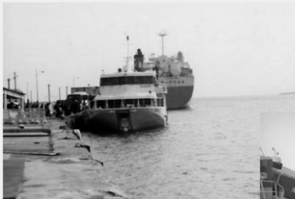
整備前（岸壁使用）
