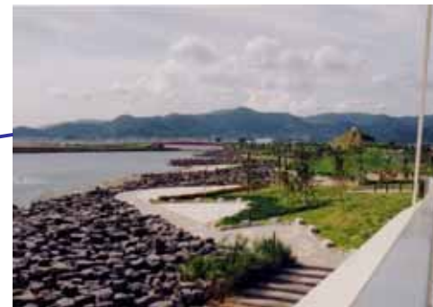
【緑地】(三河港:愛知県) 出所) 愛知県三河港務所資料
