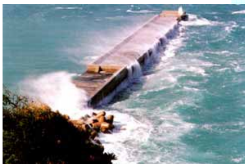
【防波堤】(名瀬港:鹿児島県)
