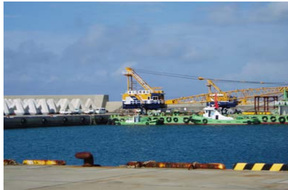
港湾工事(イメージ)
