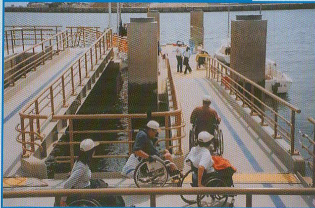
車いすのまま船に乗ることが出来るように配慮されています。(ユニバーサルデザイン)
