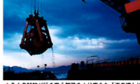
▲多くの船舶が行き交う航路をより安全な「海の道」にすべく、航路の増深や拡張などの浚渫工事が進められています。（関門航路）
