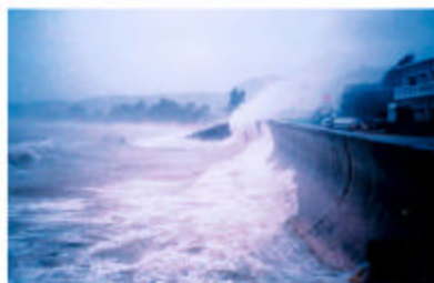
▲高潮などから背後地域に住む人々の生命や財産を守ることは非常に重要です。 〔金武湾海岸 沖縄県〕
