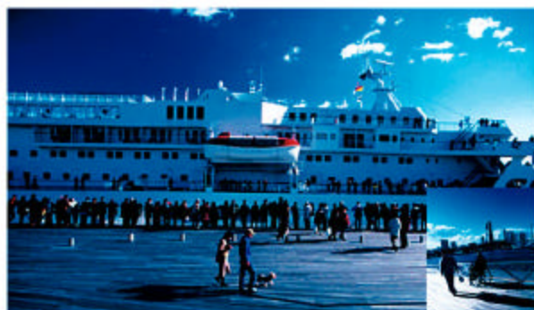
▲全ての人に優しい空間を目指して港湾施設のバリアフリー化を進めます。(横浜港)
