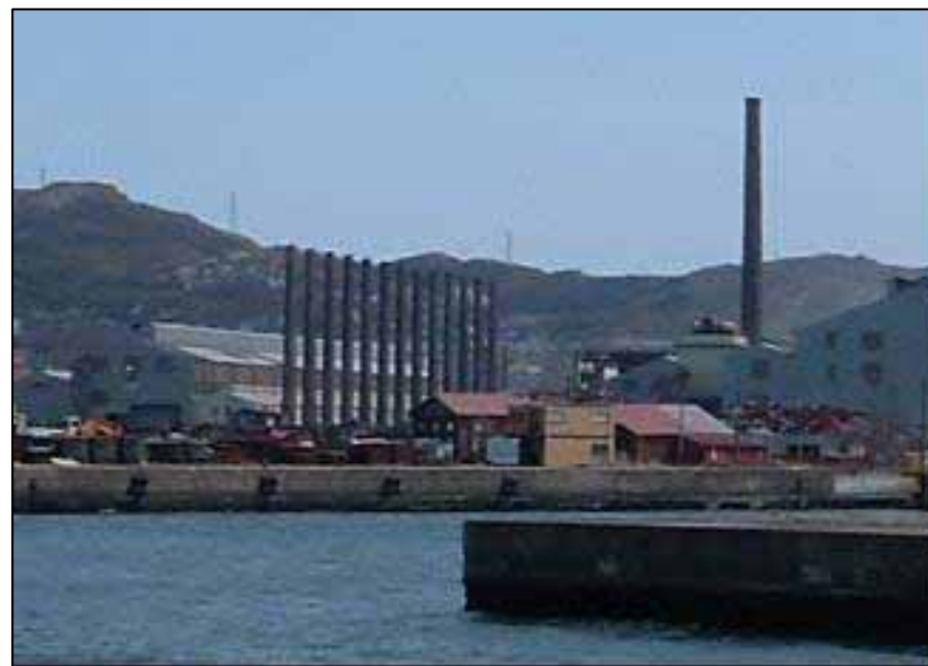
日本製鋼所13本整列煙突現況
