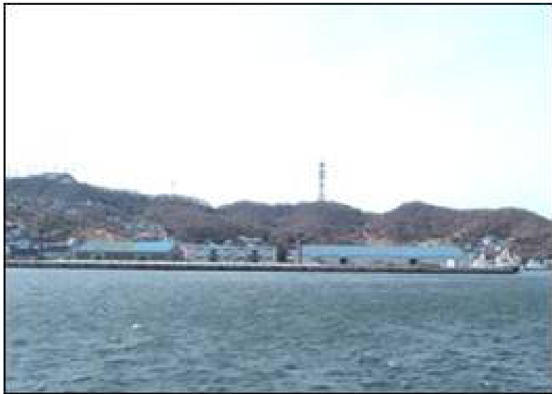
市営3号倉庫現況
