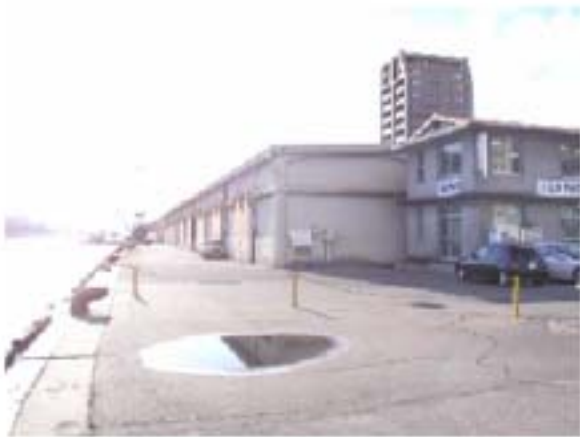
写真 3.3 区分の岸壁（尾道系崎港）
