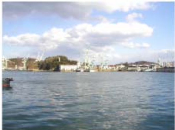
写真 3.8 造船所等の施設は、大規模で圧迫感を感じる場合もあり、水面越しやある程度の距離を設けて眺める方が望ましい場合もある。(尾道糸崎港)
