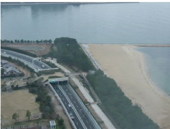
写真 4.3 道路を半地下構造として人のアクセスを容易にし、分断感を軽減している例（博多港）
