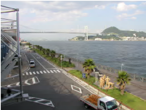
写真 4.9 護岸等は、間近で出入港する船舶を眺められる良好な視点場である。(下関港)
