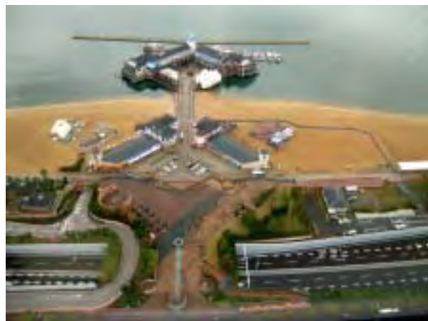
写真 4.4 道路を半地下構造とし、周辺施設等と一体的にアクセス路の整備がなされている例（博多港）
