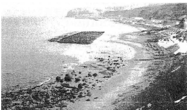
消波堤（整備後）
