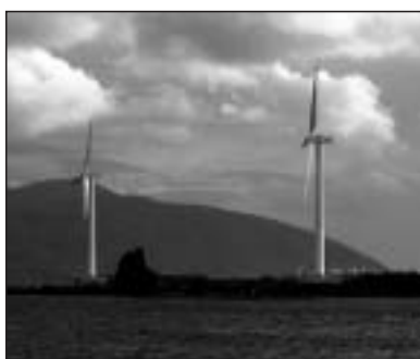
瀬棚港洋上風力発電施設
