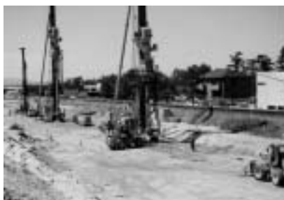
耐震補強(液状化対策)の実施
