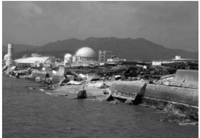
広島県広島港護岸の被災( 台風18号 )
