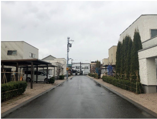
写真：ケーブル直接埋設構造による地中化
