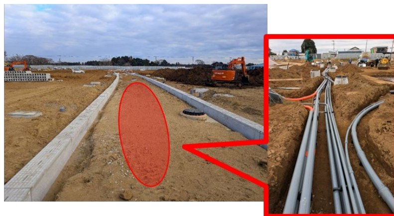
無電柱化まちづくり促進事業を活用した無電柱化の実施事例(千葉県芝山町)
