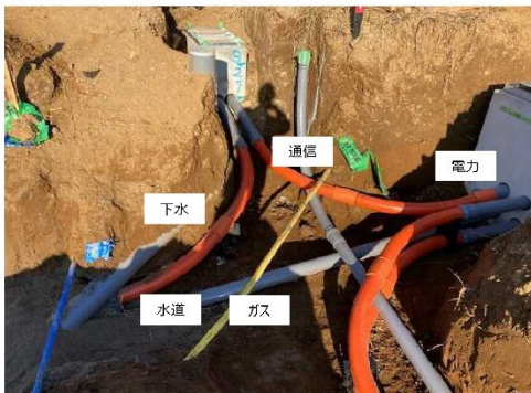
22年10月17日～22年12月20日（電力・通信工事）
