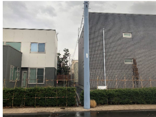
写真：通信線の迂回配線
