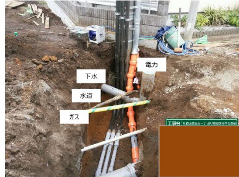
22年10月11日～10月25日（電力・通信工事）
