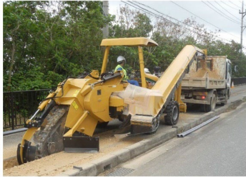
【写真】 トレンチャーの作業形態（掘削+土砂排出）
