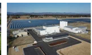
再エネを利用した 水素製造施設 (出典) NEDO
