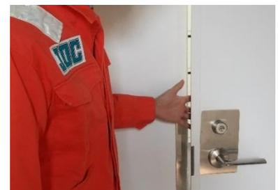
船上では火災を防ぐための防火扉が採用されています。水密扉と同様に、扉は常に閉められていなければなりません。また、非常時に備えて扉の開閉を妨げるような物を近くに置かないようにします。
