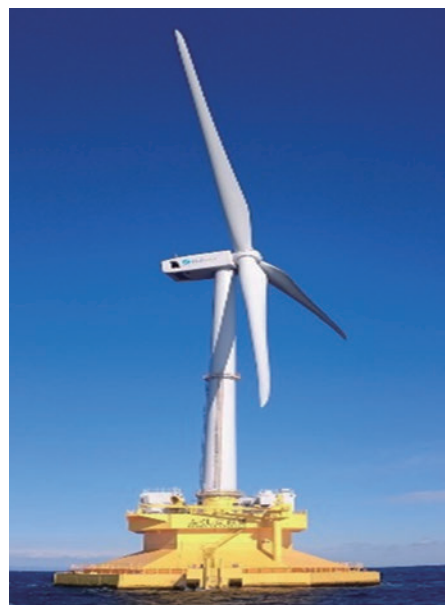
浮体式洋上風力発電施設
