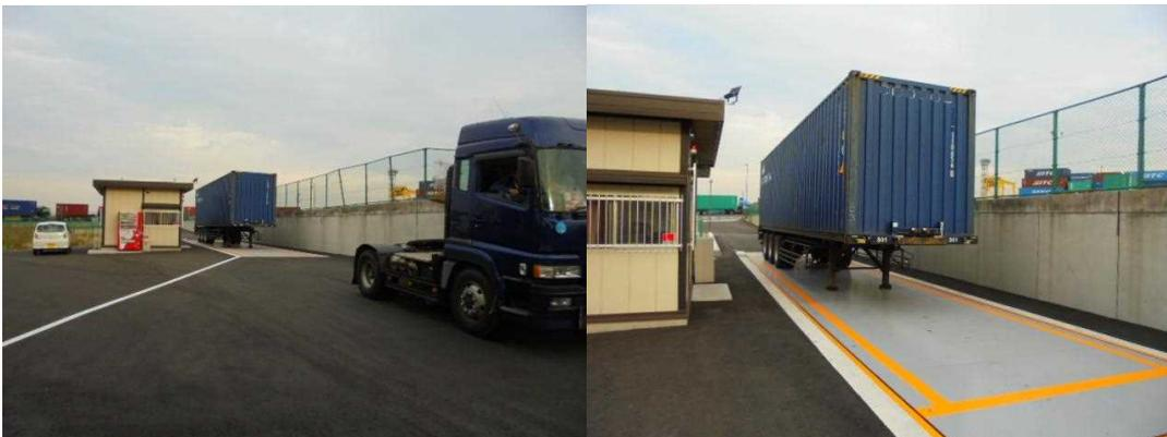
トラクターヘッドを切り離れた計量の例（ピット式トラックスケール）
