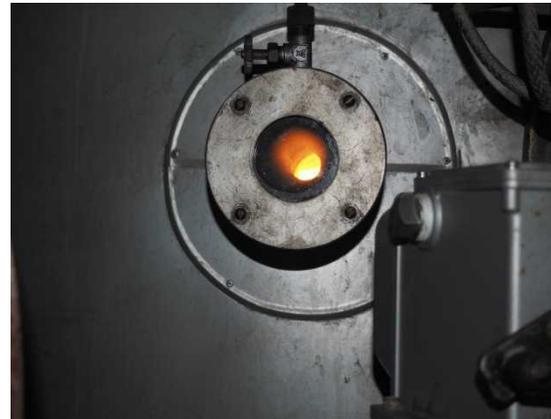
ボイラの燃焼状況（B24使用時）
