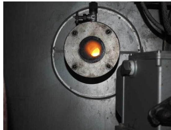
ボイラの燃焼状況（B24使用時）
