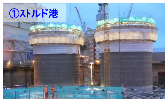
①ストルド港 ・ストルド港で、浮体基礎下部20mを製作
