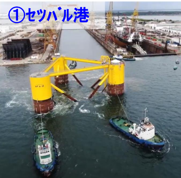
①セツバル港 ・セツバル港ドックで2基の基礎浮体を製作後、基地港湾であるフェロルへ曳航
