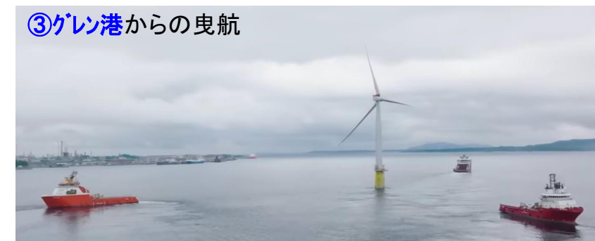
③グレン港からの曳航 ・アッセンブリ後、グレン港から沖合140kmのハイwindタンペンサイトまで曳航、設置 ・設置場所の水深は260~300m
