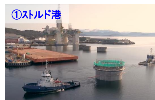
①ストルド港 ・浮体基礎上部をドマースネスへ曳航
