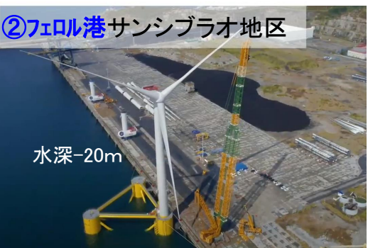
②フェロル港サンシブラオ地区 水深-20m ・水深20mの岸壁でアッセンブリをクローラークレーンで実施 ・工事時の浮体基礎の喫水は17-18m程度と想定される。
