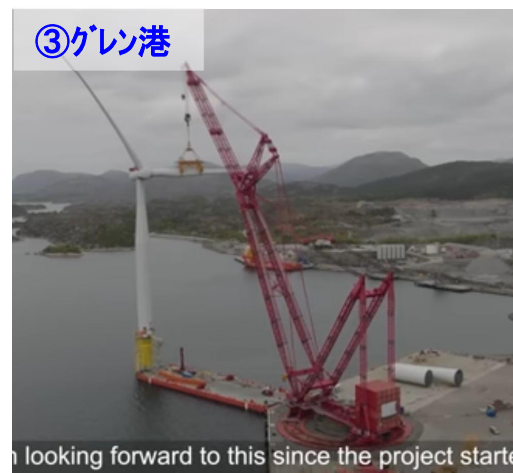
③グレン港 ・ドマースネスからグレン港まで浮体基礎を曳航し、リンガークレーンを使いSGRE社※がスパー基礎上でアッセンブリ
