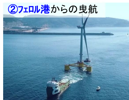
②フェロル港からの曳航 ・完成した浮体式洋上風力発電設備を大型タグで曳航し、事前に設置した係留索に固定。 ・設置場所の水深は100m
