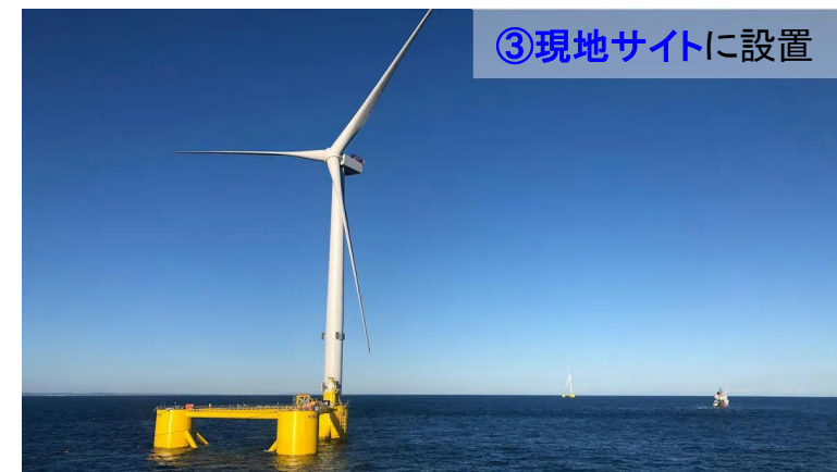
・現地サイト設置後の様子 ・設置場所の水深は60～80m
