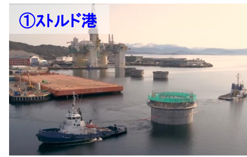
・浮体基礎上部をドマースネスへ曳航
