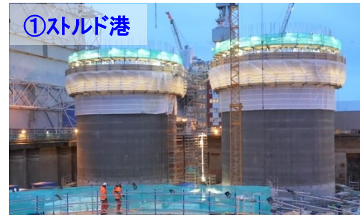
・ストルド港で、浮体基礎下部20mを製作
