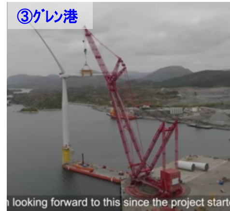
・ドマースネスからグレン港まで浮体基礎を曳航し、リンガークレーンを使いSGRE社※がスパー基礎上でアッセンブリ
