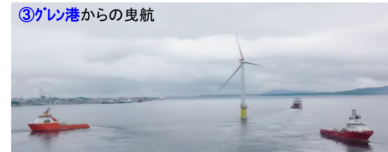
・アッセンブリ後、グレン港から沖合140kmのハイウィンドタンペンサイトまで曳航、設置 ・設置場所の水深は260~300m
