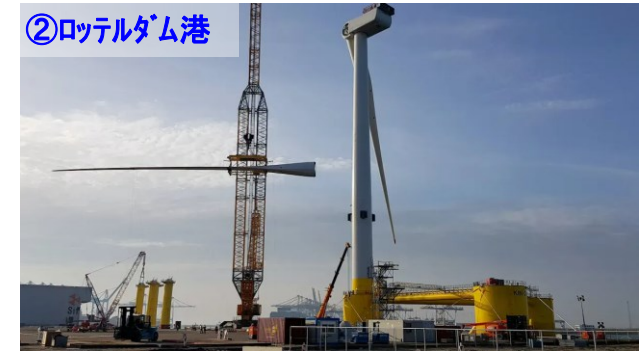
②ロッテルダム港 ・ロッテルダム港でアッセンブリ
