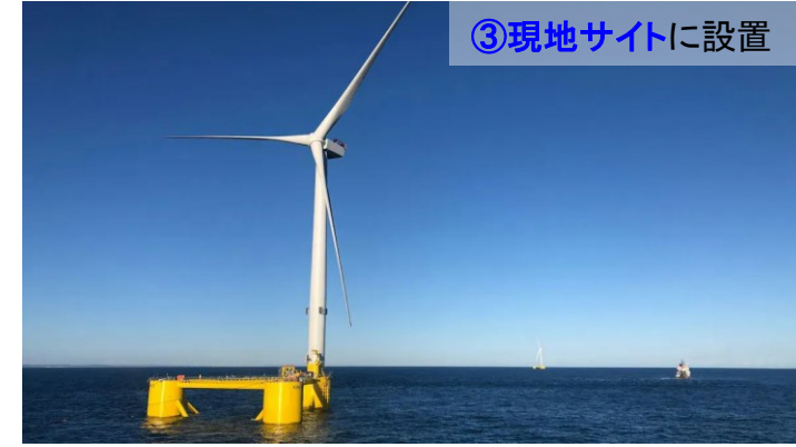
③現地サイトに設置 ・現地サイト設置後の様子 ・設置場所の水深は60~80m
