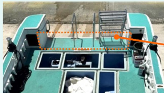
写真2 仕切り板の取り付け
