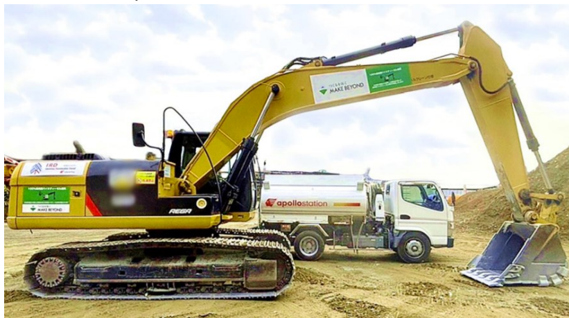
【2024年12月 / 建設現場へのHVO供給】
