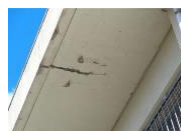
校舎等の天井・壁面
